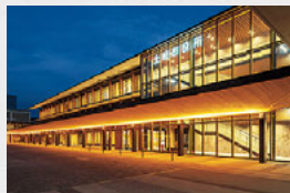
平成31年 市役所新庁舎
