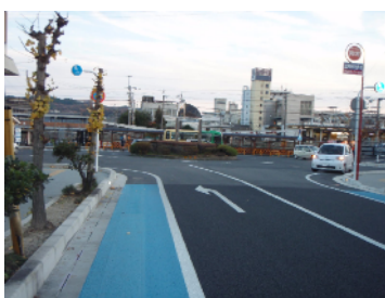
土岐市駅北側
